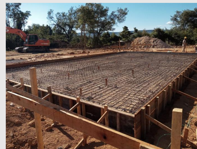
Bases da Estação de Tratamento de Esgoto, CRES, Barreiras
