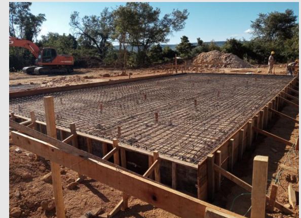
Bases da Estação de Tratamento de Esgoto, CREB, Barreiras
